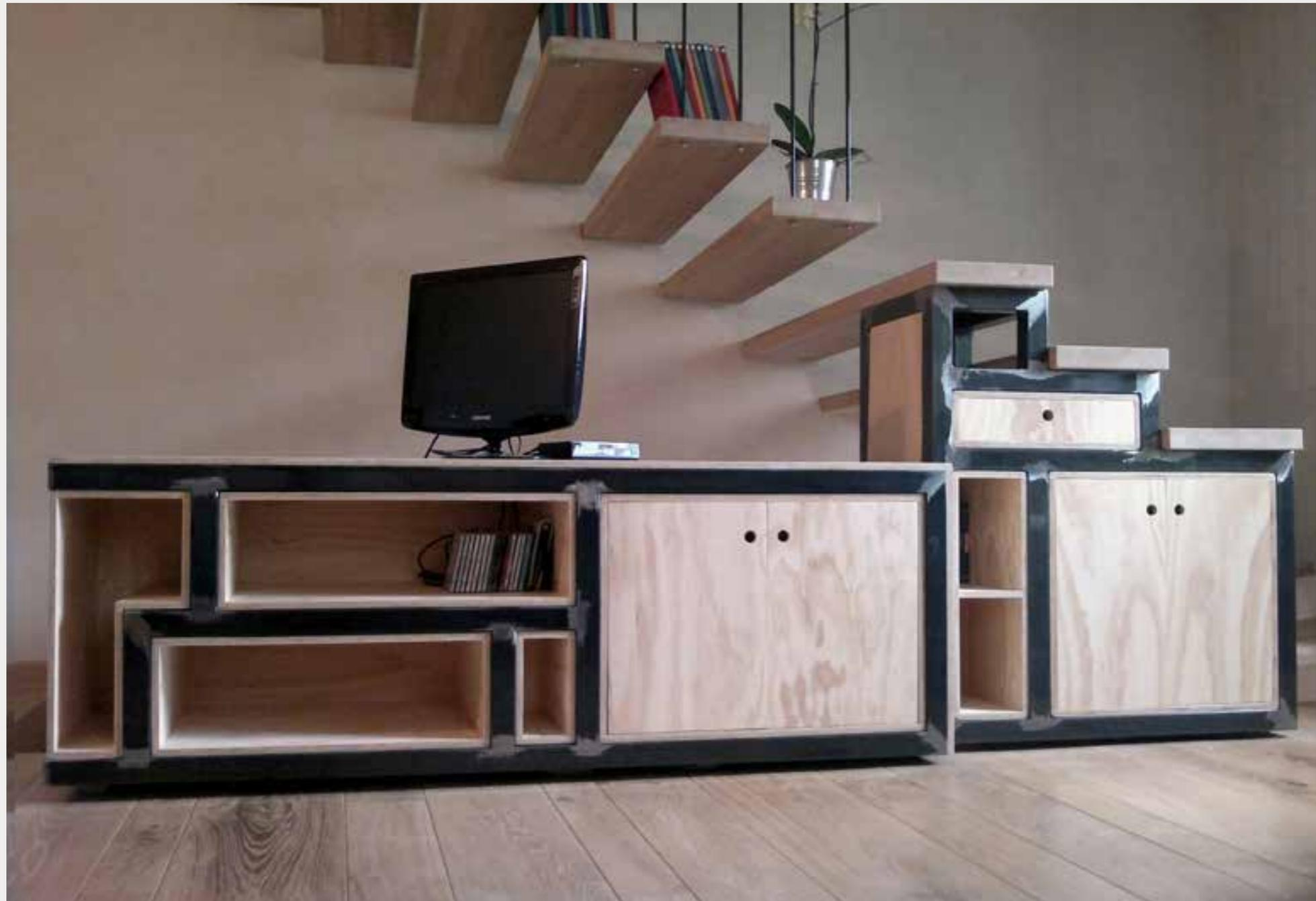
STRUTTURA DI SOSTEGNO AD UNA SCALA IN FERRO CHE DIVENTA MOBILE CONTENITORE
